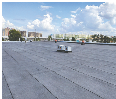
Кровля здания мойки троллейбусов в СТТ
