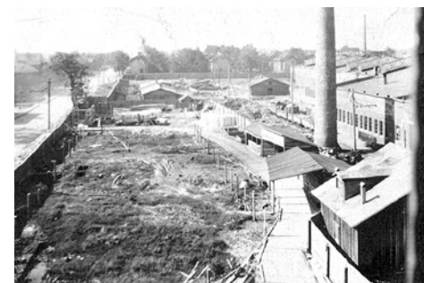
Строительство Троллейбусного парка № 2
